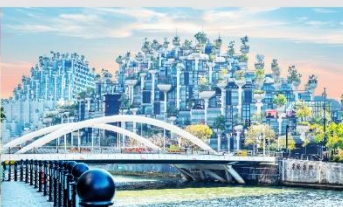
อาคารฟันทันไม้
