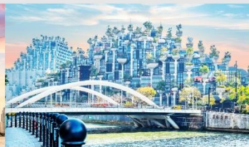
อาคารฟันทันไม้
